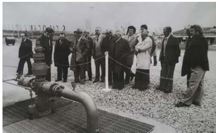
Travaux dans les années 60, en présence d'Henri Mery, maire, et Jean Claude Groul, 2ème adjoint.
